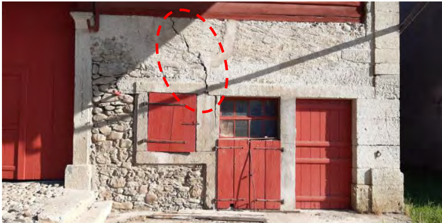
Figure 2 : Photo d'une fissure constatée sur la façade Sud de la ferme sise parcelle 14.
